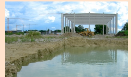
Der entstehende Gewerbepark trägt in der Gemeinde Inning deutlich zum Flächenverbrauch bei (Foto: Manfred Lehner).
