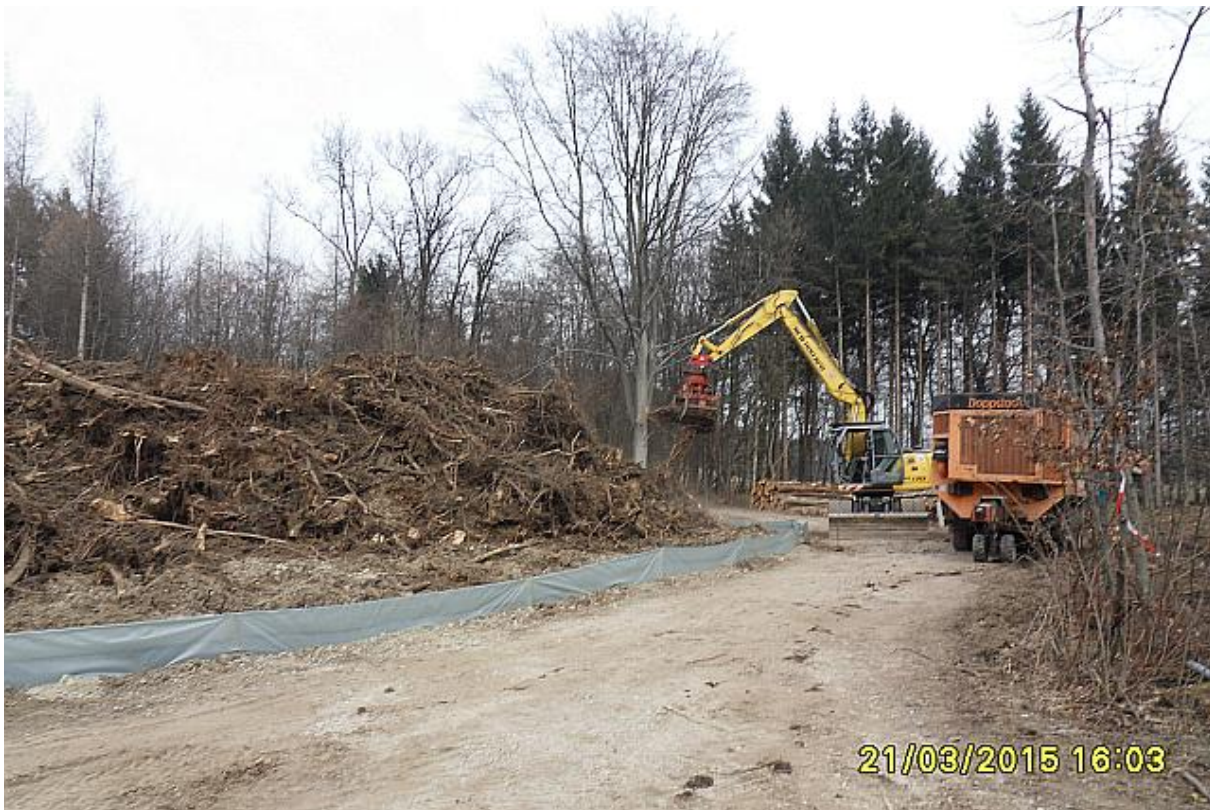
Foto 2: Weßling-Mitterwies, Wurzelstöcke werden in der Ruhezeit geshreddert
